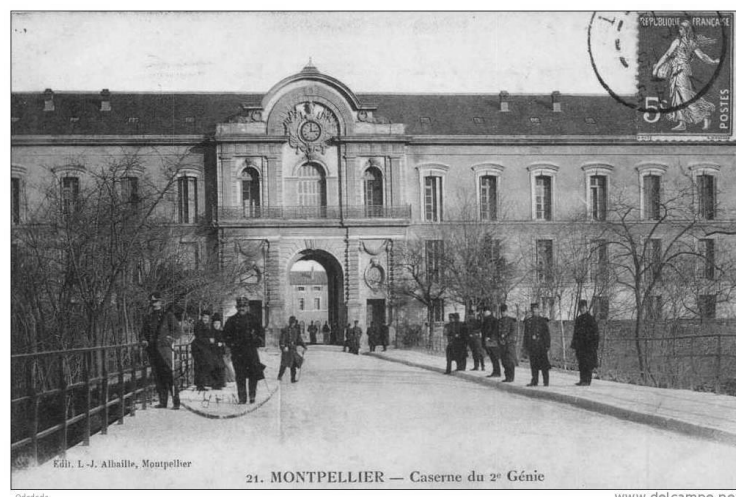
La caserne du 2 e ème génie à Montpellier.
