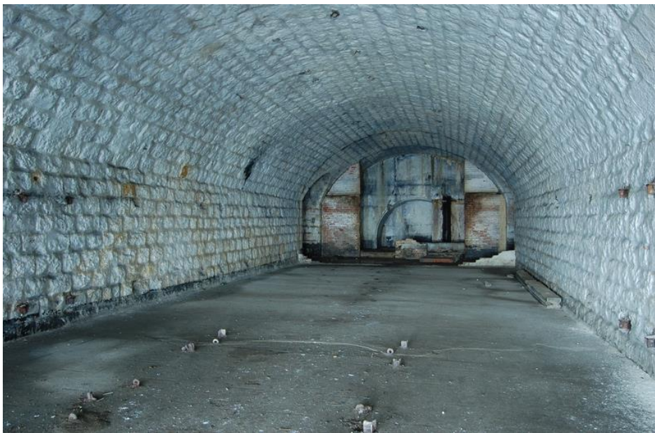
Fort de Moulainville. La chambrée 19. Etat actuel. ((Photo J. Vaubourg)
