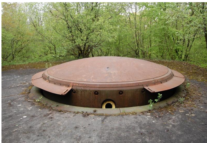
Fort de Moulainville. La tourelle de 155R. État actuel. (Photo C. Vaubourg)
