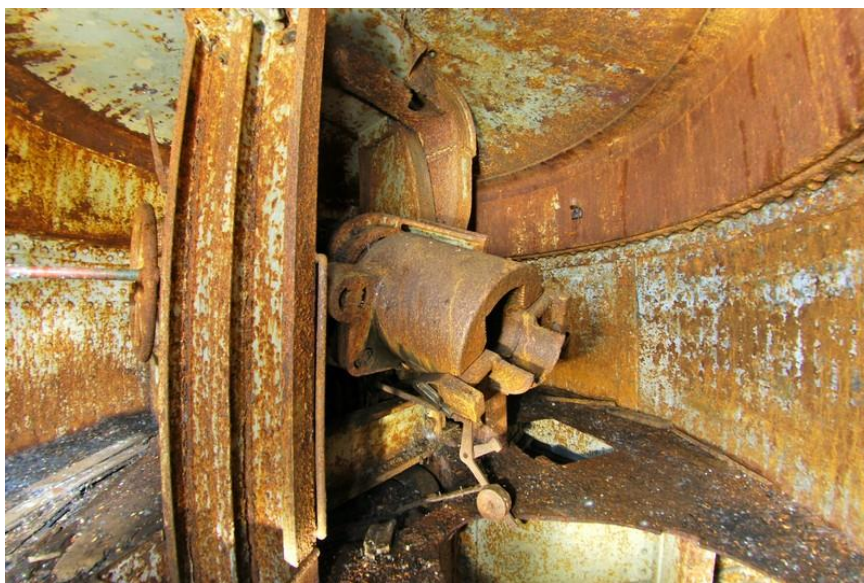
Fort de Moulainville. La chambre de tir de la tourelle de 155R (Photo C. Vaubourg)
