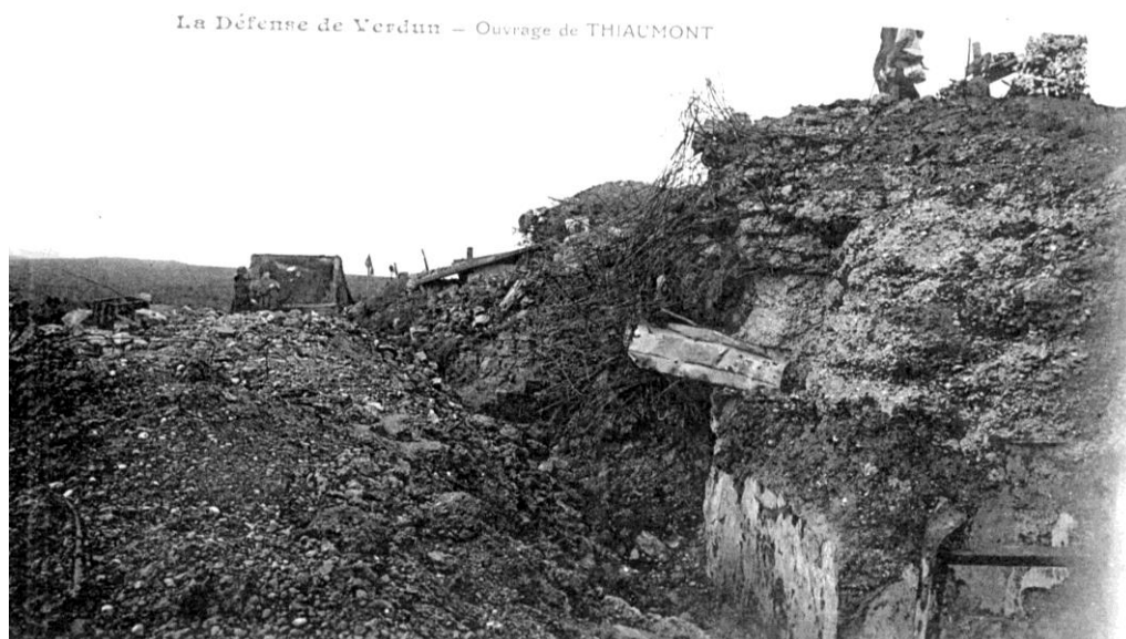
L'ouvrage de Thiaumont
